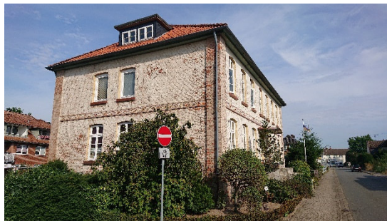
Abb. 2 Uelzener Straße 5 / Uelzener Straße 6
